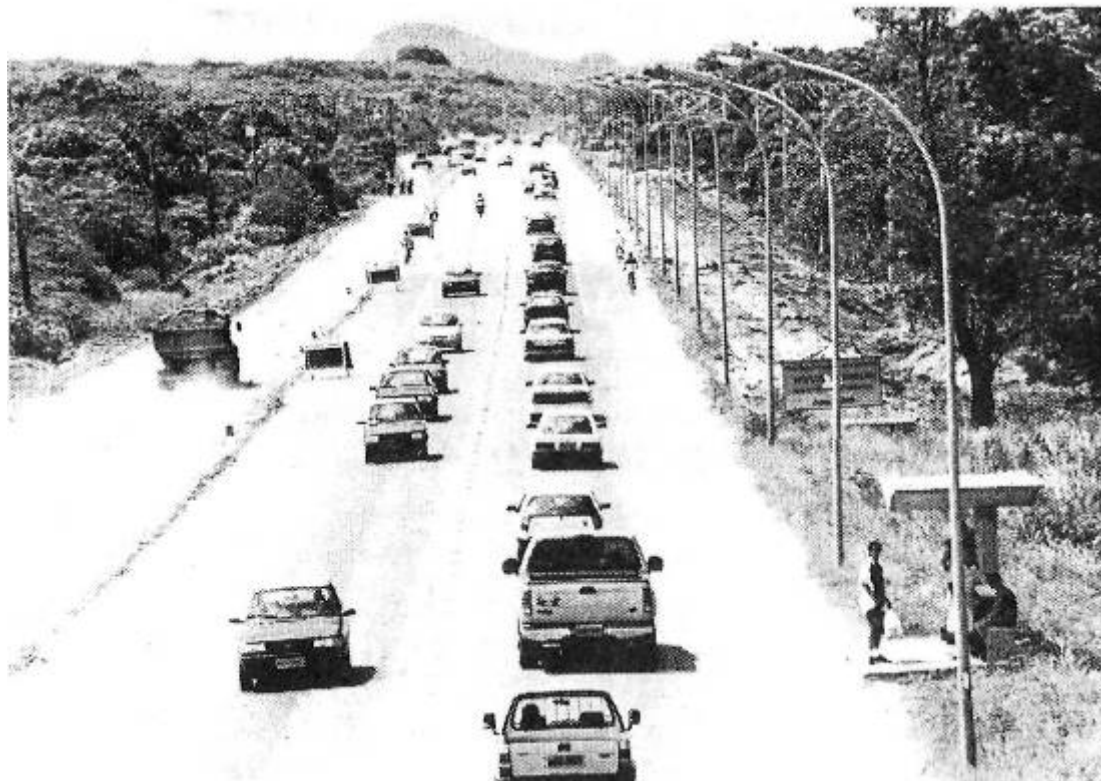
Obras correspondentes à duplicação da Rodovia do Sol
