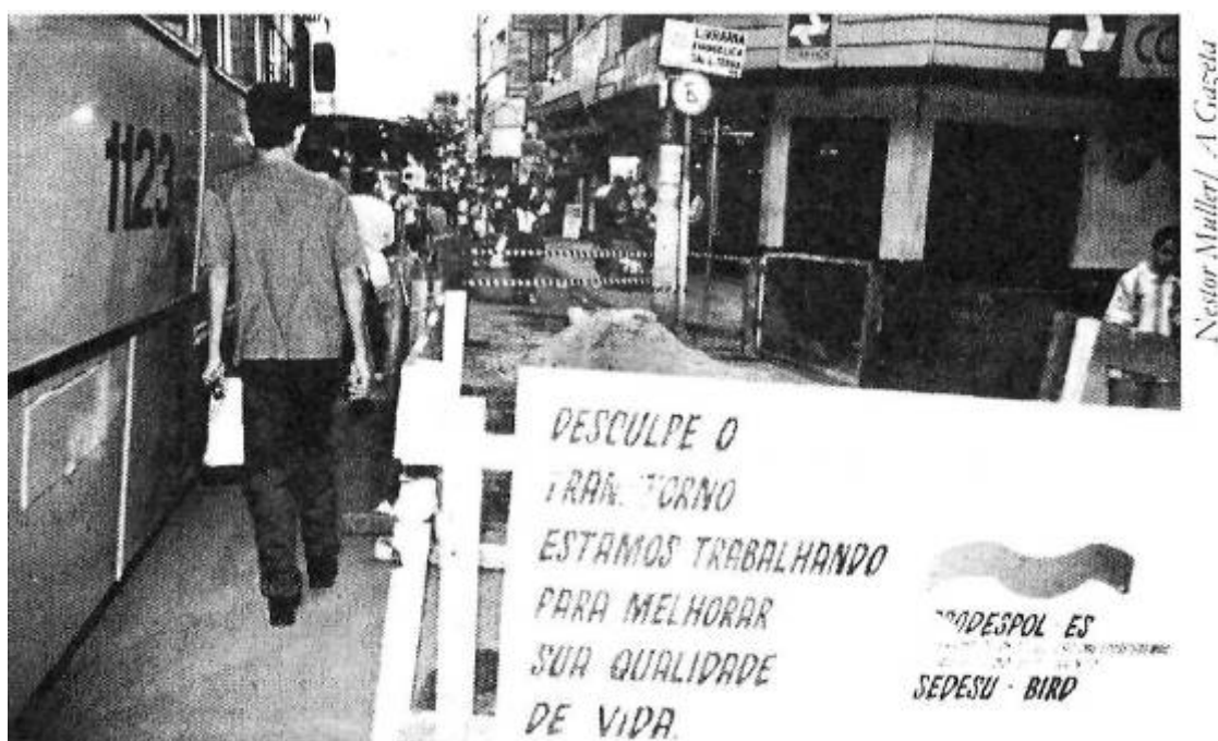
Obras do Prodespol atrapalham o trânsito de pedestres em Campo Cirande
